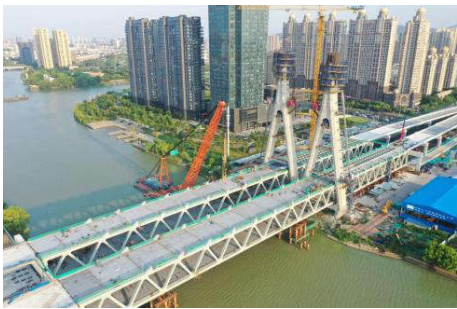
主体结构吊装完成影像
