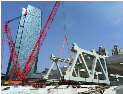
桁架片稳定措施
