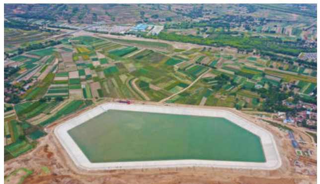
引洮二期王家河调蓄水池俯景
