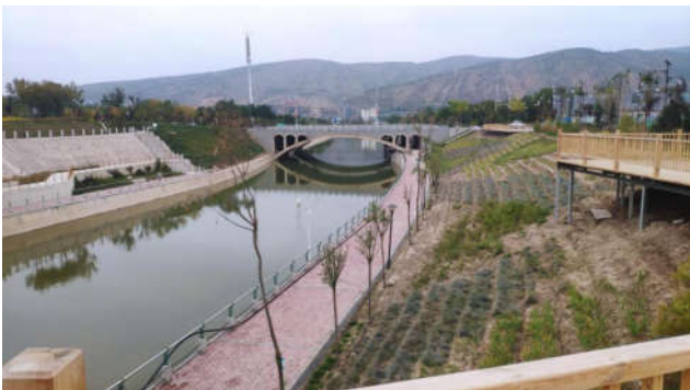
安定区大碱沟水生态项目
