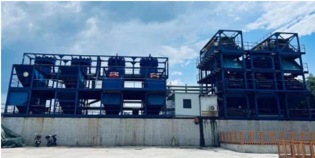
图2 泥水处理固控系统现场安装图
