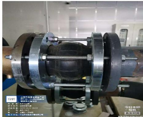
图6 软接与法兰临时固定措施
