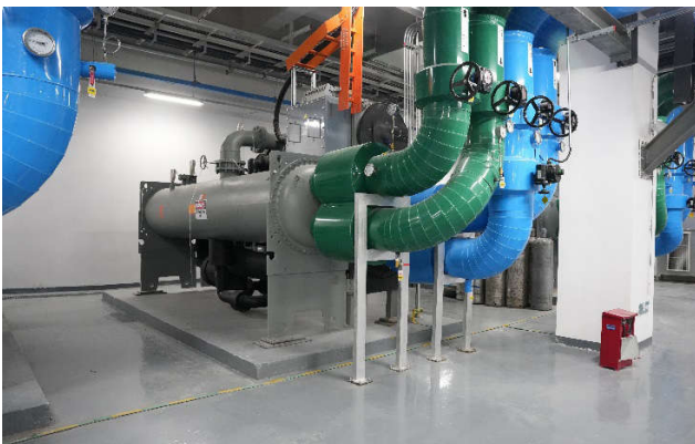
图1 某电子项目制冷系统安装图
