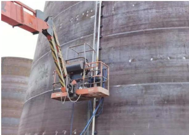
图7 钢圆筒垂直气电焊
