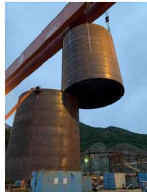
图3 钢圆筒上下段吊装合拢
