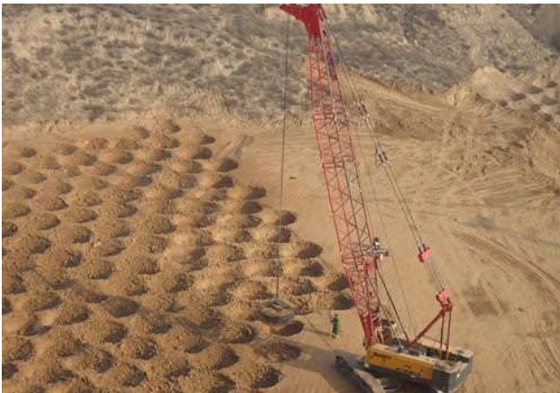
图1 强夯处理地基的施工步骤如图所示
