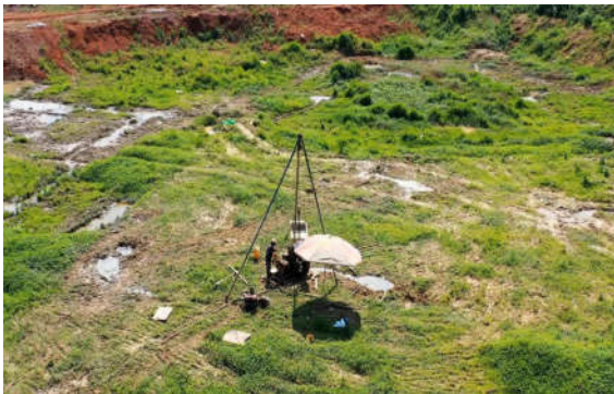
工程地质勘察工作现场如图所示
