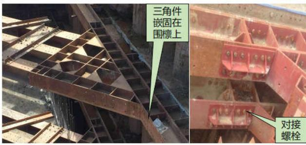
图7 支撑与钢围檩连接
