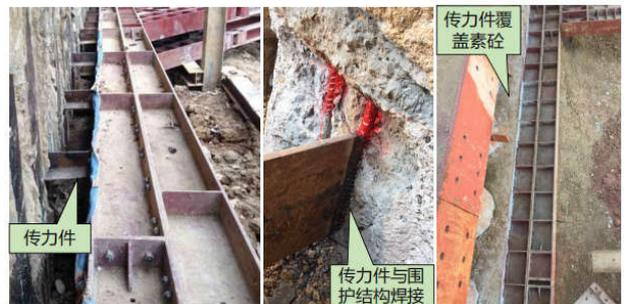
图6 钢围檩与围护桩连接
