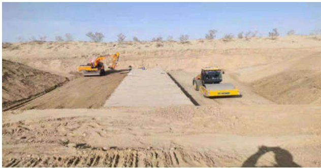
图2 砂石垫层压法施工
