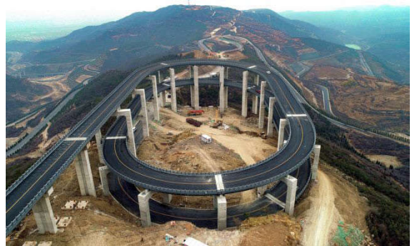
图1-1 桥面铺装及全桥景观照片
