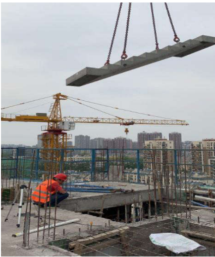
图1 构件绿色施工技术的建筑工程施工建设
