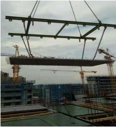
图2 结构体系中的施工操作现场
