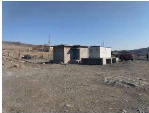
图2.4 吐库线某通信基站
