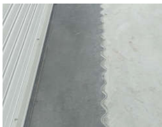
图5 铠甲缝处完成混凝土浇筑图
