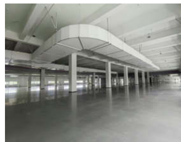
图10 地面整体完成图
