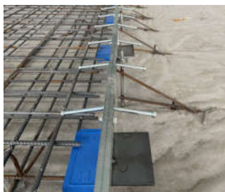
图4 铠甲缝安装完成图
