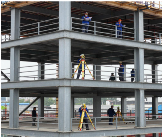
图 1 钢结构安装梁架布设施工现场图
