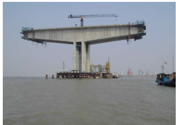
图1 连续梁桥挂篮施工
