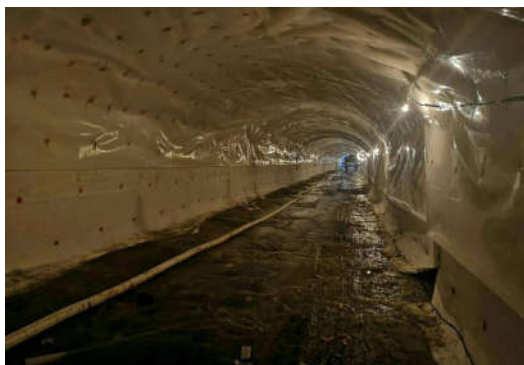
隧隧道防水施工如图1所示
