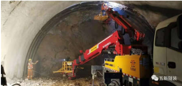
隧道工程施工设备如图一所示
