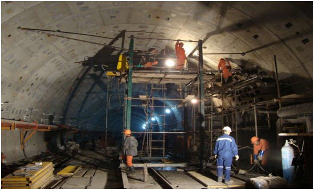
联络通道冻结管打设工程图如图1
