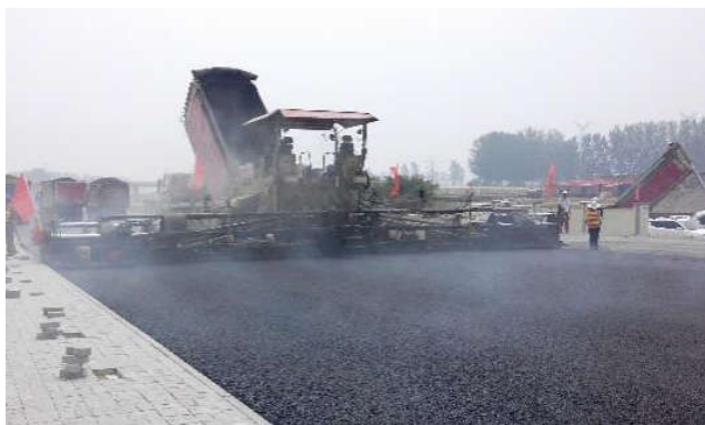
图1 热拌沥青混合料施工
