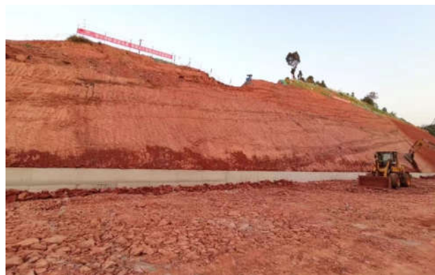
图1 红层区斜向倾内斜坡结构特征
