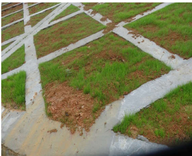
图2 红层填方边坡渗流破坏特征
