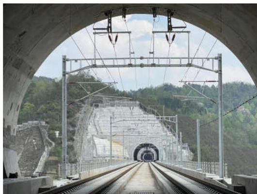
图一：接触网桥隧结合处施工工艺
