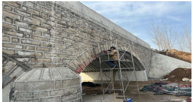
图4 洞口侧模封堵
