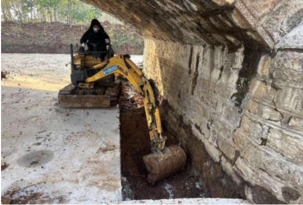
图1 拱座基础开挖
