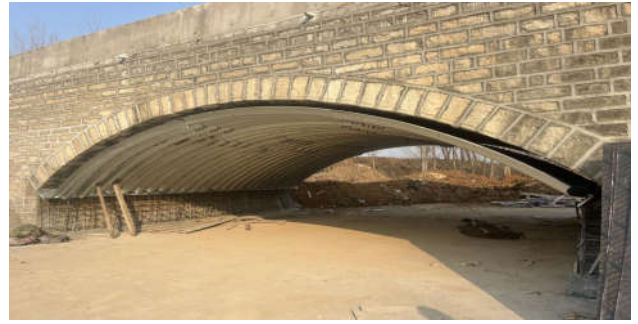
图3 波纹钢拱安装就位后
