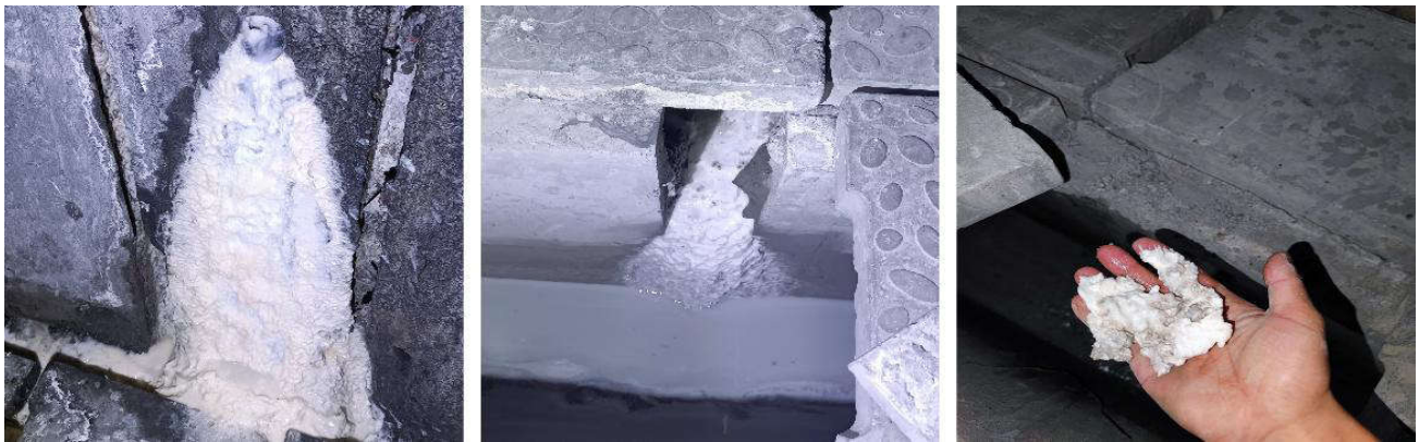
图1 排水系统结晶堵塞
