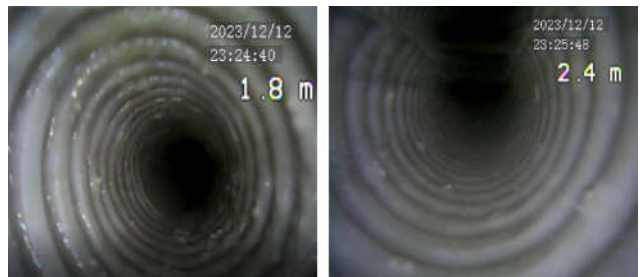
图7 清洗后管道内部情况
