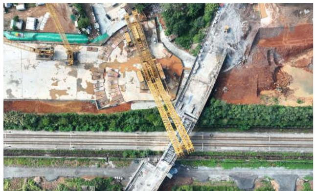
图2 履带吊吊装拆除现场实施情况
