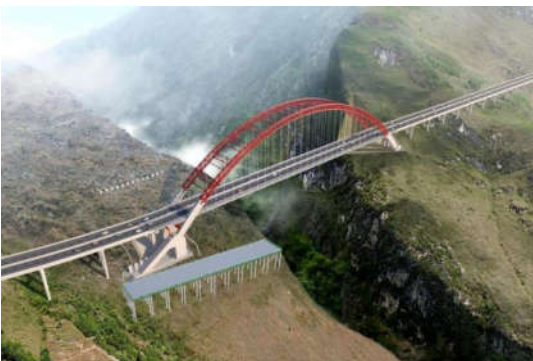
图1 桥址区全装配化施工平台效果图
