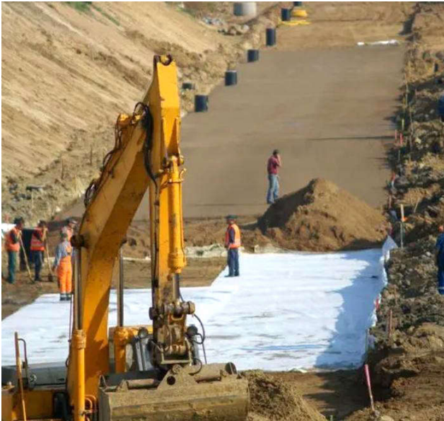
图2 换填法施工
