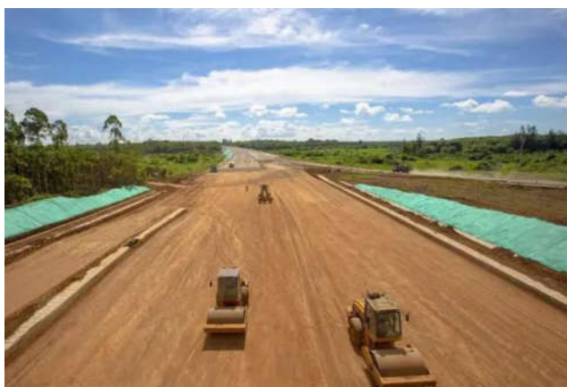
图1 道路工程软土地基处理
