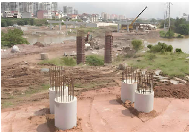
桥梁桩基础施工如图所示
