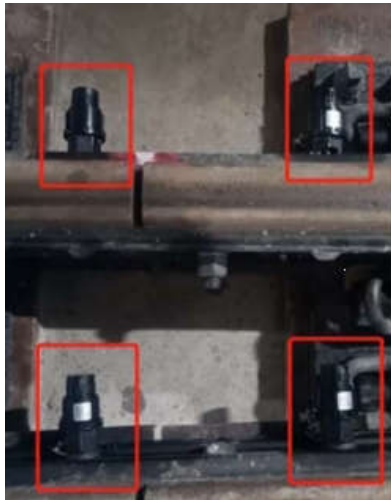
图2 螺栓松动监测示意
