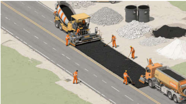
图1 沥青混凝土路面的施工场景
