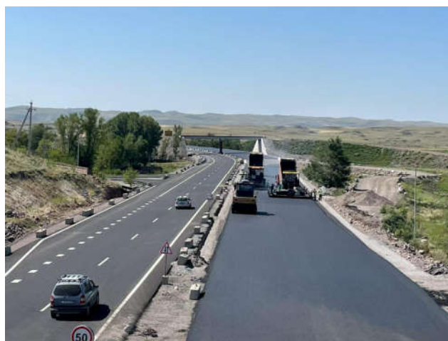
沥青混凝土碾压如图2所示
