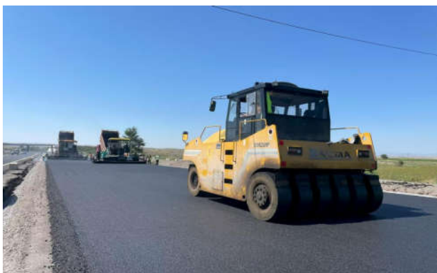
沥青混凝土摊铺如图1所示
