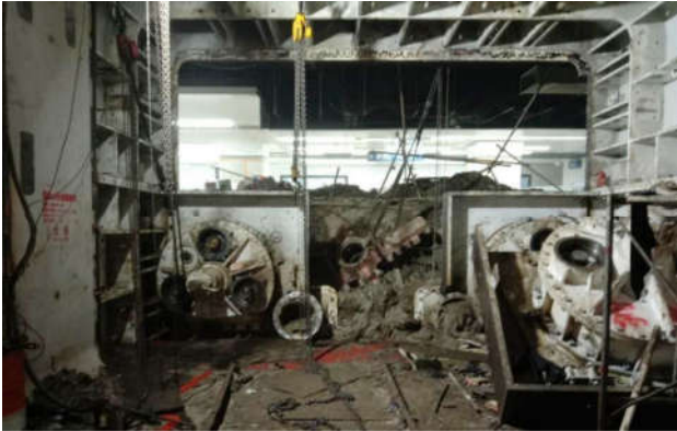
图3 顶管机分体接收图
