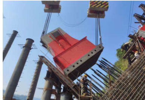
图4 锚箱滑入式对位安装示意图
