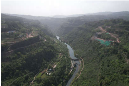
图2 凤来大溪河特大桥地貌
