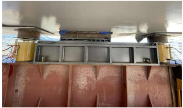
图1 顶推滑移系统
