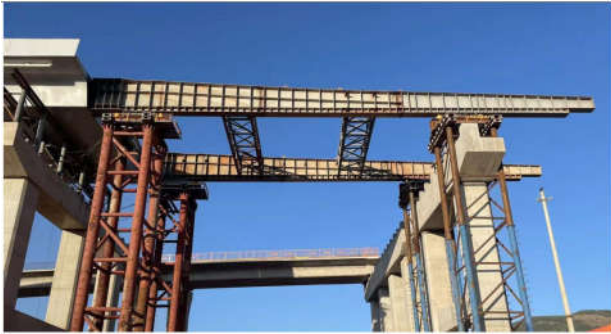
图4 钢导梁结构图
