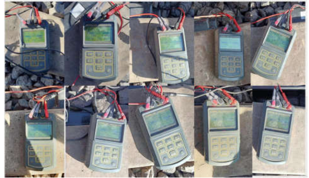
图6 补偿电容现场测试情况图
