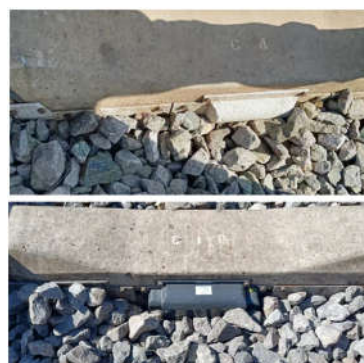
图4 原补偿电容与信息型补偿电容现场安装对比图
