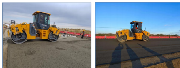
图 1：双钢轮压路机进行初压
