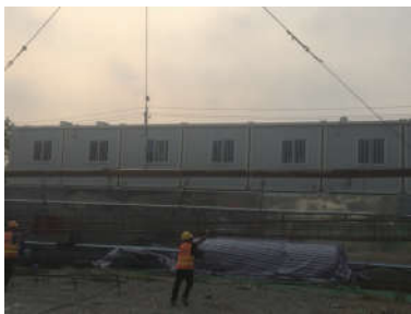
图3 钢筋笼起吊现场施工图
