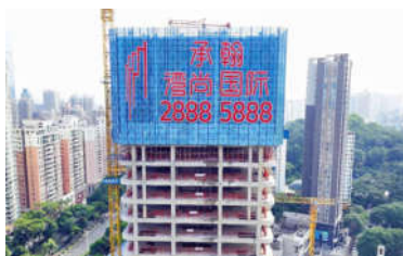
悬挑盘扣式外脚手架+冲孔钢板网照片
