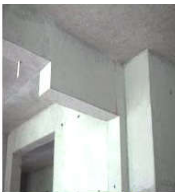
做法2 混凝土下挂板
