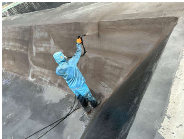
图3 喷涂速凝橡胶沥青防水施工
