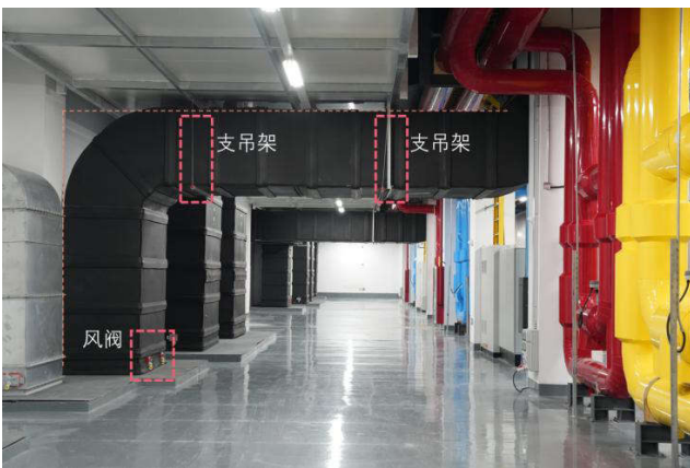
图2 某半导体厂房的风管安装图
