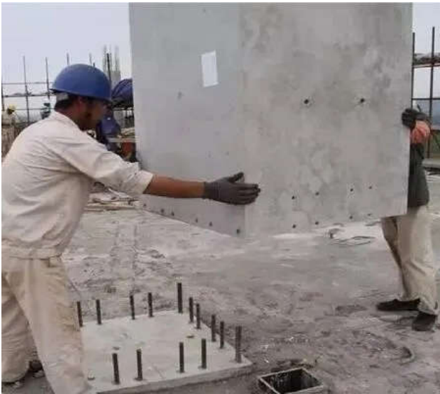
图1 钢筋套筒灌浆连接施工技术图示
