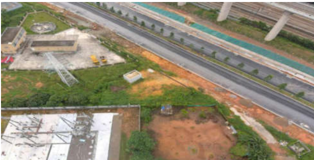
图3 无人机开展外部隐患排查
