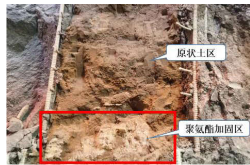
图8 洞门凿除效果检查示意图
