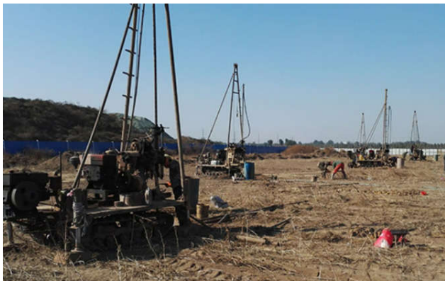
图1 某水利工程的勘察现场
