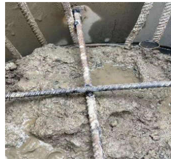
图2 横向钢筋支撑定位现场示意图
