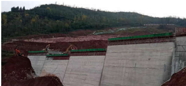
图17 石柱县垃圾坝实景图
