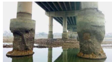
图1 桥墩腐蚀
