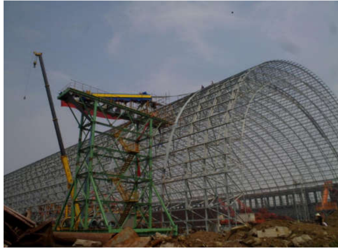
图2 上承式可移动高空压板平台装置施工实例图片
